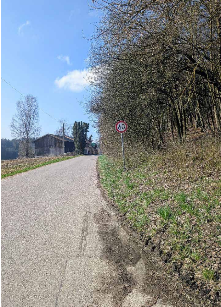
Hier soll der neue Gehweg für mehr Sicherheit entstehen
