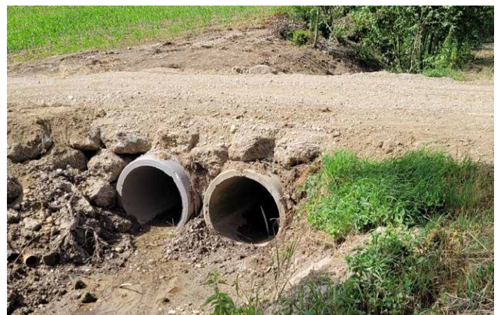
Ein zweites Durchlassrohr wurde eingebaut
