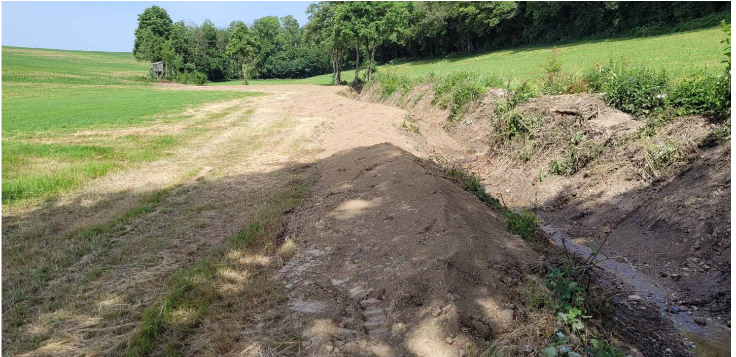
Gräben wurden gesäubert
