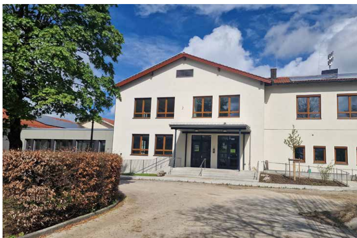
Außenansicht Sanierung Altbau
