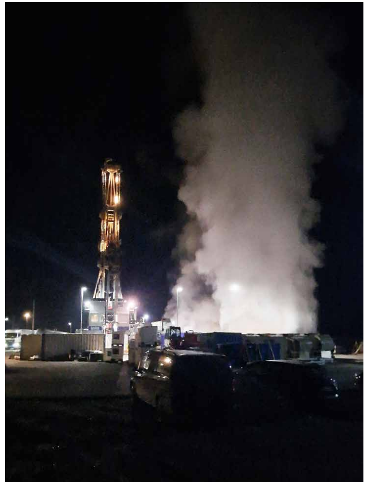
Geothermiebohrung bei Nacht
