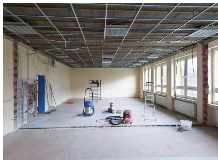
Der Umbau ging zügig voran
